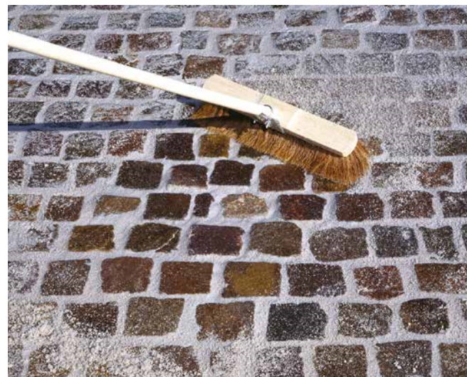
6 Oczyszczenie zaspoinowanej okładziny.
