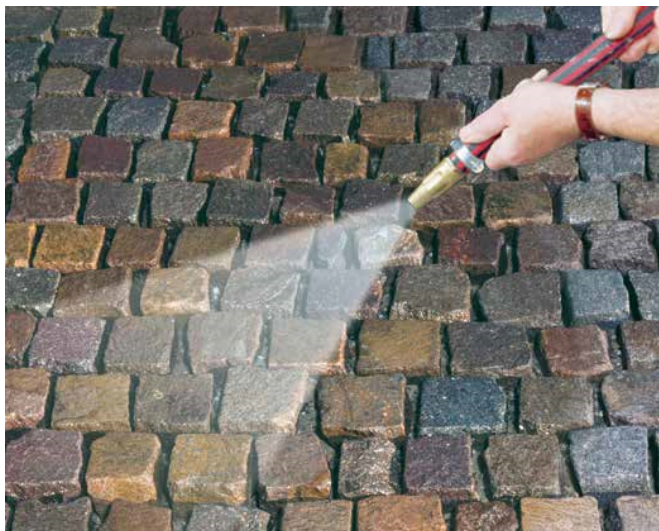
1 Nawilżona, wyczyszczona okładzina, przygotowana do spoinowania.
