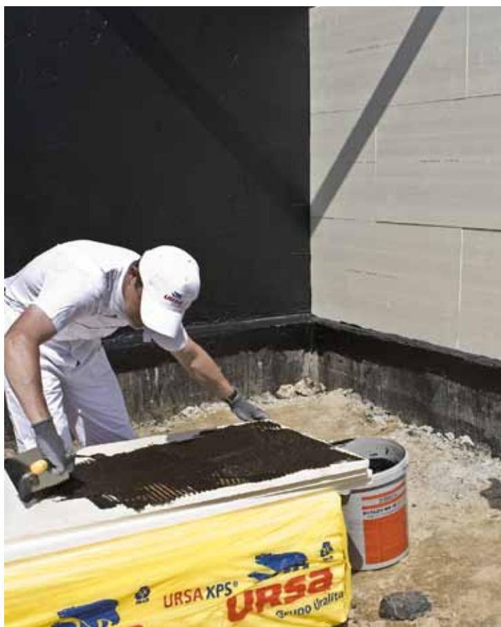
Zdjęcie 3 – Przyklejanie płyt URSA XPS przy naporze wody gruntowej
