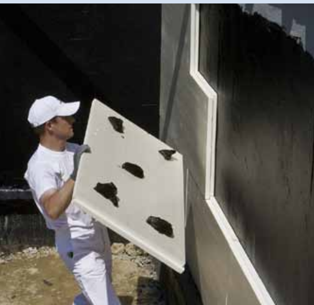
Zdjęcie 2 – Przyklejanie płyt URSA XPS metodą na placki
